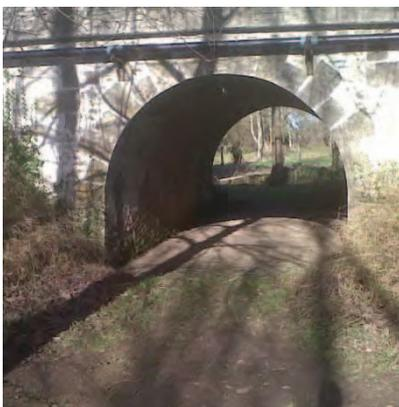
L'ouvrage OD2 est similaire à l'ouvrage OD1, situé en rive droite à une trentaine de mètres de la berge. Le radier se situe également au niveau du terrain naturel.
